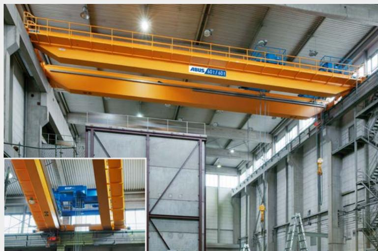
L'utilisation de 2 sommiers couplés formant bogies, reposant sur 8 galets, permet une répartition optimale des charges verticales par galet. Cela signifie par exemple, que pour un chemin de roulement existant, on peut soulever des charges plus importantes, sans pour autant renforcer le chemin de roulement (après note de calcul).
