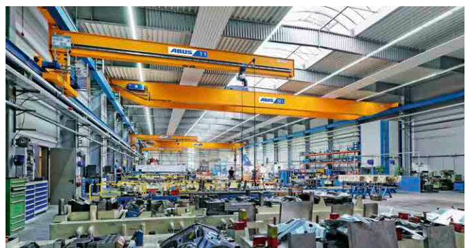
Montage final sur les machines-outils
